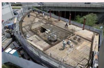
▲ 一樓地板的水泥澆築作業 (2012/4/16)
