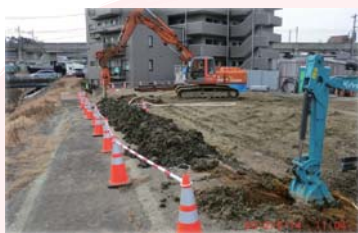
▲ 先從地盤改良開始，增加地盤的穩定性 (2012/2/14)
