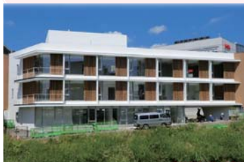
▲ 內部工程進行中 (2012/8/20)
